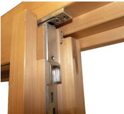
Offene Fugen zwischen erstem und zweitem Flügel sind Schwachstellen
