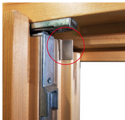
Die Fuge ist abgedeckt
