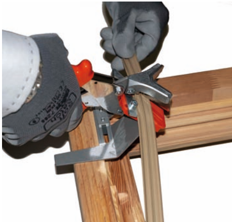
Dichting in de juiste positie knippen
