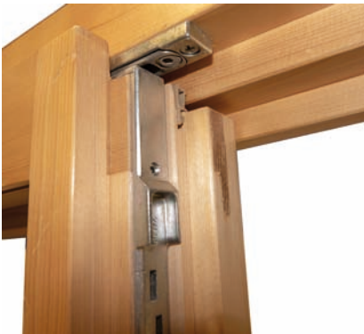
Open voegen tussen het passieve en actieve raam zijn zwakke punten
