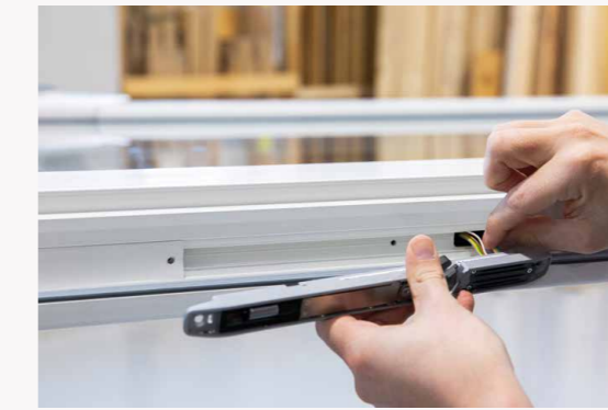
Schritt 2: Verschlusskomponente anstecken und in die Beschlagsnut einsetzen
