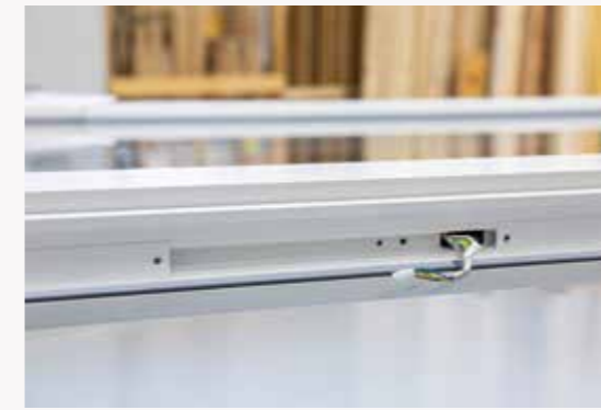
Stap 1: Steek de kabel in en monteer het afdekprofiel
