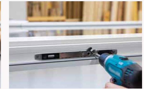
Stap 3: Schroef het vergrendelingsonderdeel vast in de beslaggroef.
