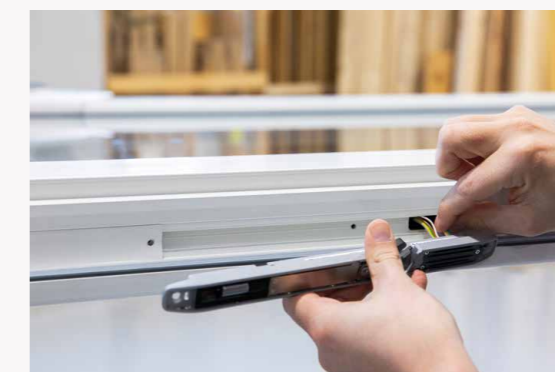
Krok 2: Připojte uzamykací komponentu a vsaďte ji do drážky pro kování.
