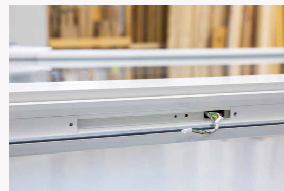
Krok 1: Zaveďte kabel a namontujte krycí profil.
