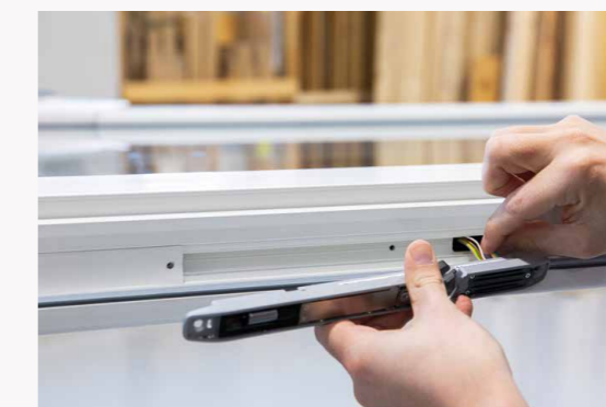
Krok 2: Zamocuj moduł ryglujący i włóż go do rowka montażowego
