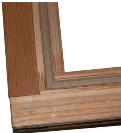
Tagliare la guarnizione nella posizione corretta
