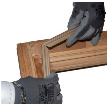
Per la corretta definizione del punto di taglio, regolare il cursore sulla battuta
