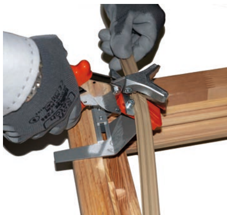
Tagliare la guarnizione nella posizione corretta
