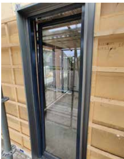
Остеклённая дверь с фурнитурой MACO Multi Power и вентиляционной стойкой в проёме с большим зазором (положение для летней вентиляции)
