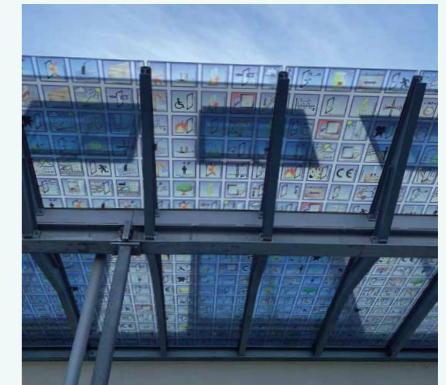
Die Liebe zum Detail wird schon am Eingang sichtbar: Die ganzheitliche Bewertung von Bauprodukten durch das ift Rosenheim sind im Vordach am Eingang verbildlicht.
