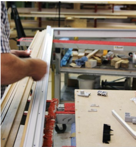
Die Dichtungsschiene wird angebracht.
